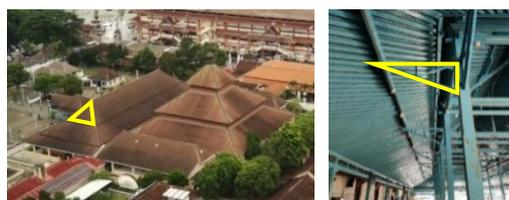
Gambar 6 Atap dan Kerangka Atap Masjid yang Memuat Konsep Segitiga
