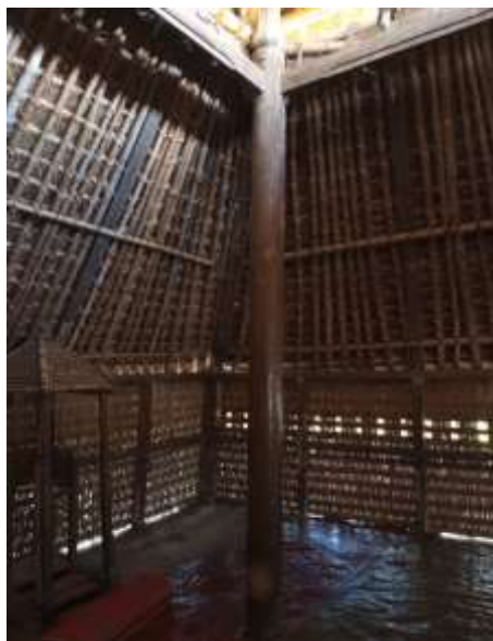
Gambar 1 Tiang Masjid Kuno Rambitan
