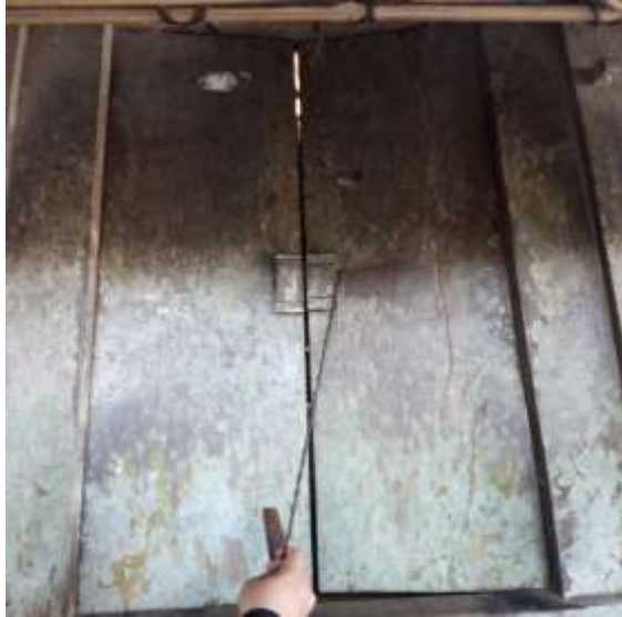
Gambar 2. Pintu Masjid Kuno Rambitan
