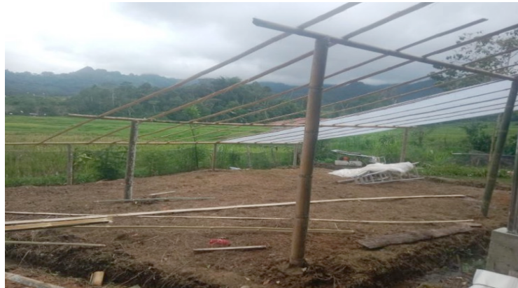
Gambar 3. Proses Pembuatan Greenhouse Sederhana dengan Konstruksi Bambu
